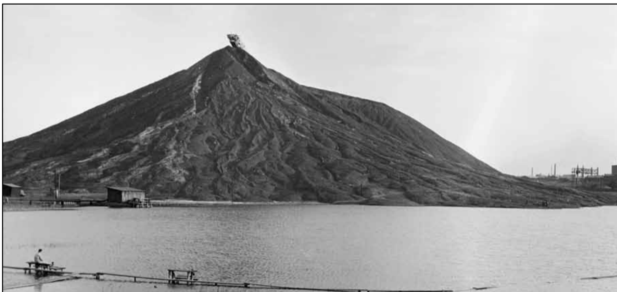
Obr. č. 3: Pohled z železničního náspu na provozní odval, 21. 4. 1961 (Foto Rudolf Janda).
