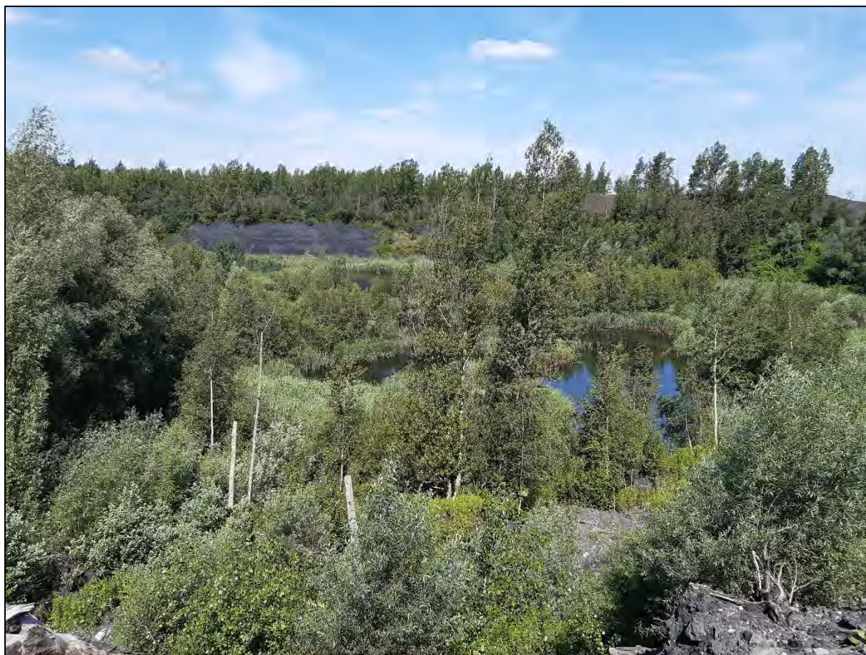
Obr. č. 4: Nádrž K2, pohled od jihu
